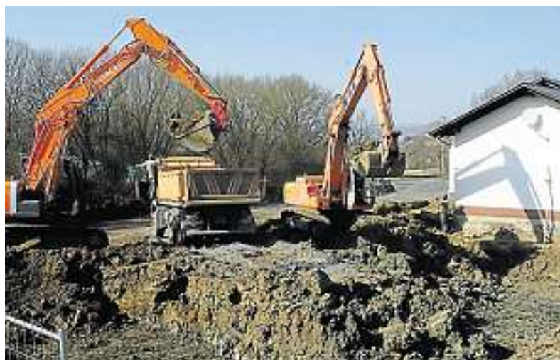
Zwei Bagger heben die Baugrube für das zentrale Feuerwehrgerätehaus der Elbtaler Wehren in Dorchheim aus. Foto: Häring
