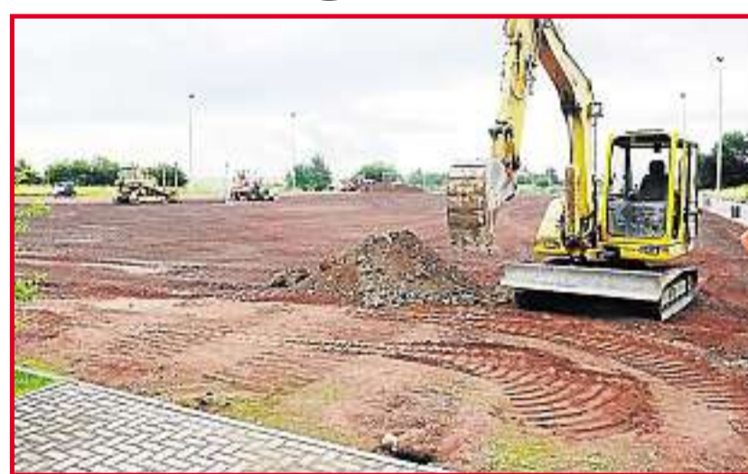
Auf der Zentralen Sportanlage ist mit dem Abbau des Tennisplatzes begonnen worden. Bis Mitte August soll dort ein Kunstrasenplatz entstehen. Foto: Lormann
